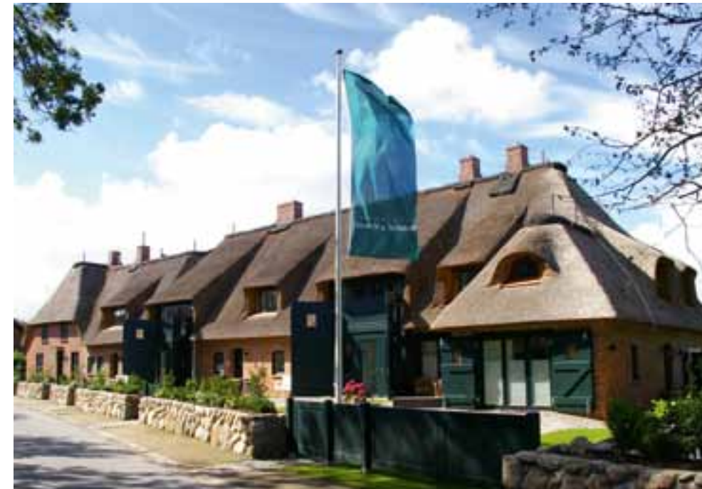
Oevenum: Kernsanierte Hausteile unter Reet
